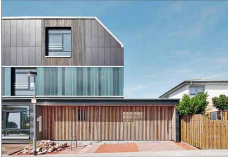
Fassade des „Recyclinghauses“ in Hannover-Kronsberg aus gebrauchten Aluminiumfenstern, Eternitplatten, Profilbauglas und Wellblech sowie Holzfassade aus alten Saunabänken
