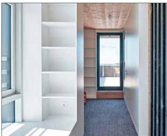
Dachgeschoss des „Recyclinghauses“: Möbel und Innenwände aus gebrauchten Messebauplatten, Absturzsicherung aus gebrauchtem Stahl, Teppich aus Recyclinggarn
