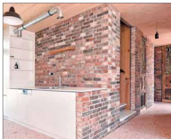
Innenwände aus Abbruchziegeln, Terrazzo „Opus Signium“ mit Ziegelsplittzuschlag
